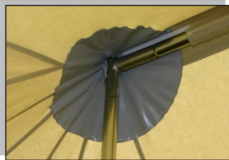
Mittelstangen in Rahmenkonstruktion ohne Ösen im Firstbereich!
