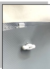
Mittelstangen in Rahmenkonstruktion ohne Ösen im Firstbereich!
