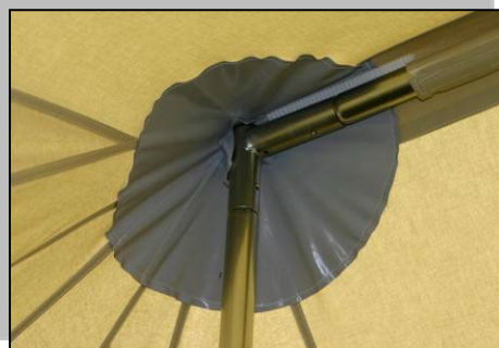
Mittelstangen in Rahmenkonstruktion ohne Ösen im Firstbereich!
